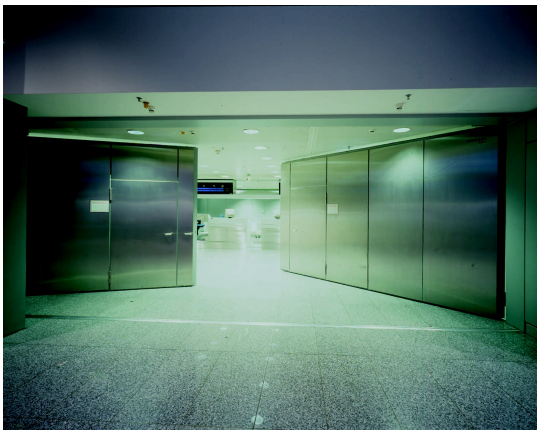
Bild 4: 2-flügeliges T30-RS Drehflügeltor System Schröders TSN-2 mit einer Breite von über neun Metern im Abfertigungsbereich
